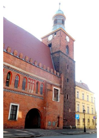
Rathaus mit Rathaustrurm von der Rückseite
