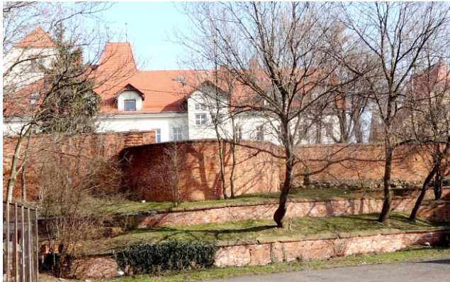
Stadtmauerrest im Burgbereich mit halbrunder Bastion, in der früher der Burgturm stand, dahinter die Gebäude des ehemaligen Amtsgerichts
